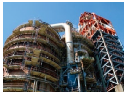
京浜製油所水江工場の重質油熱分解装置 (フレキシコカー)
