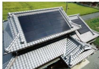
国内住宅へのソーラーフロンティア(株)製CIS薄膜太陽電池の設置事例
