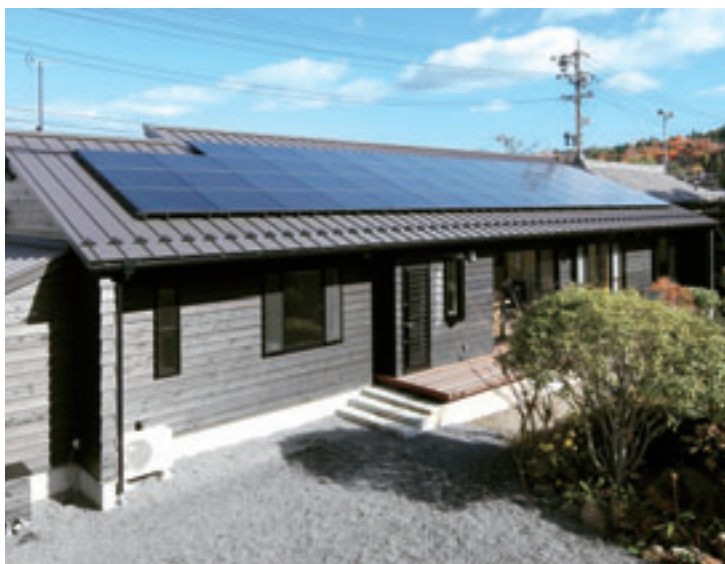
国内住宅へのソーラーフロンティア(株)製CIS薄膜太陽電池の設置事例
