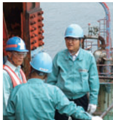
2012年7月東亜石油(株) 京浜製油所訪問時撮影
