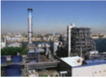
(株) ジェネックス 水江発電所
