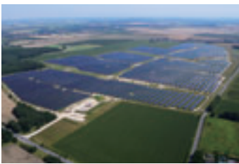
ソーラーフロンティア(株)製品を使用し、ベレクトリック社がドイツのブランデンブルク州に建設した太陽光発電所
