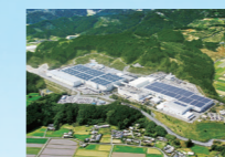
CIS薄膜太陽電池 国富工場 (2011年)
