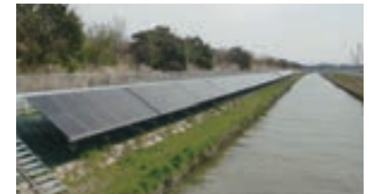
法面（のりめん）に設置された発電施設
